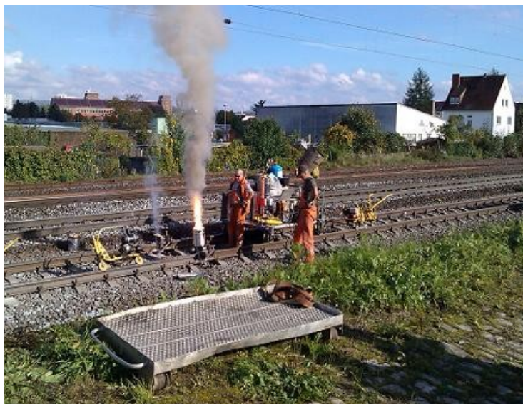
Aufnahme von den Bauarbeiten am Gleis
